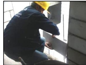
Fig.3. Murete M1. Secciones, compresora de aire, chisquete (bolsa de plástico) con epóxico, asentado de bloques y relleno de alveolos con grout.
