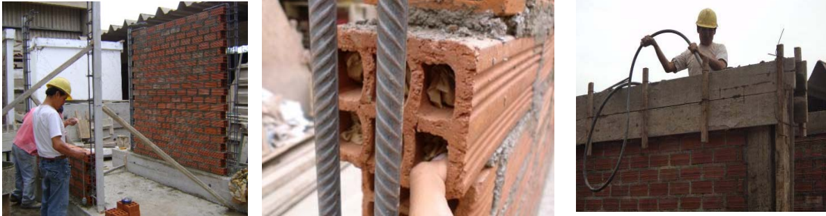
Fig.6. Construcción de M1 y M2, taponado con papel y vibración del concreto.
