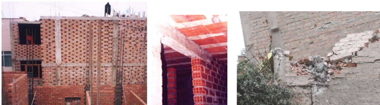
Fig.1. Viviendas con ladrillo pandereta y colapso en el sismo de Pisco del 2007.
