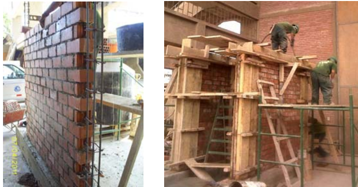
Fig.6 Construcción de los muros M1 y M2.
