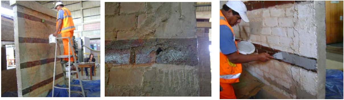
Fig.7. Aplicación del imprimante Mbrace Primer y de la pasta Mbrace Putty.
