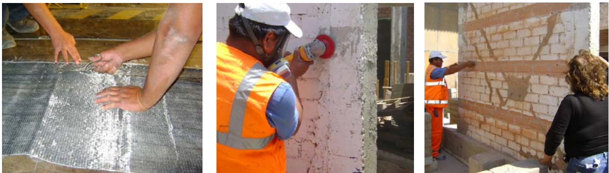
Fig.6. Recorte de la fibra de carbono, esmerilado y marcación de la zona a reforzar.
