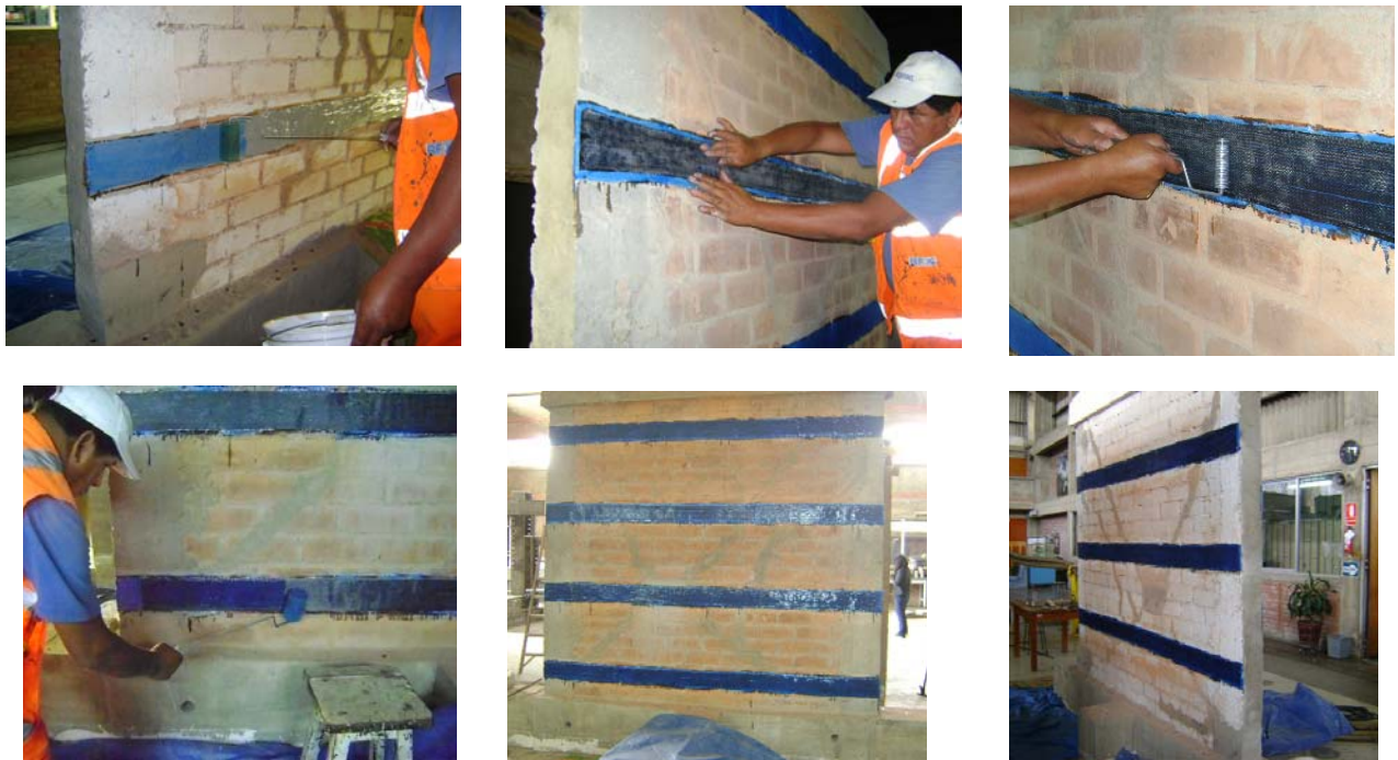
Fig.8. Aplicación del Mbrace Saturant, instalación de la banda, rodillo metálico, aplicación de la segunda capa de Mbrace Saturant y estado final del muro reparado y reforzado en las 2 caras.
