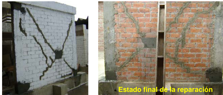
Fig.4 Etapas de la reparación.
