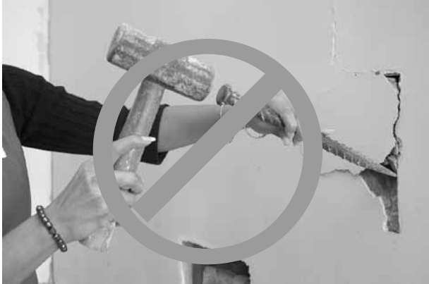
No picar directamente la pared, se deben hacer cortes
