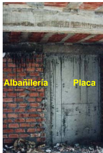
Fig.1 Unión placa- albañilería
