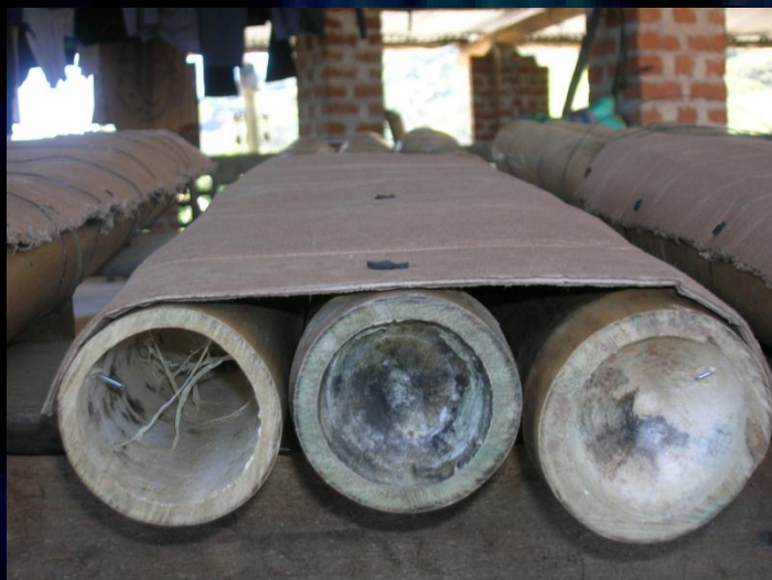
Se coloca una protección de cartón corrugado en la parte superior. Clavadas con arandelas de chapas boca arriba
