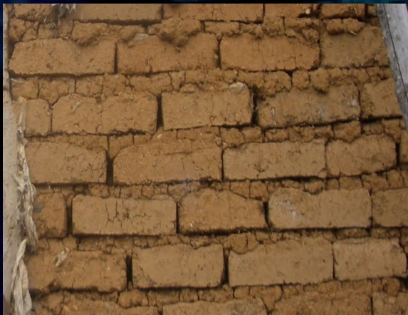
JUNTA VERTICAL SIN RELLENAR
