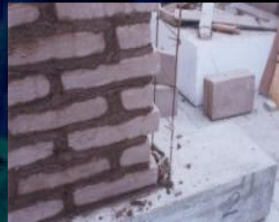
JUNTA VERTICAL Y HORIZONTAL LLENAS DE BARRO
