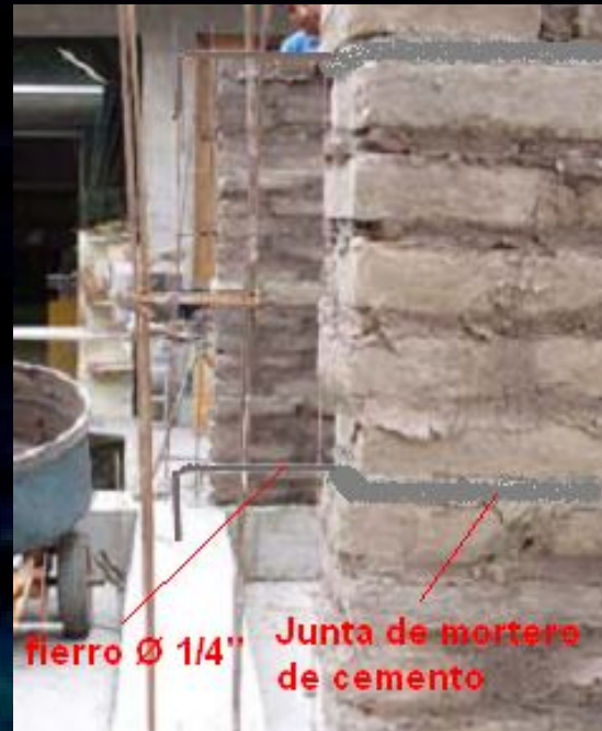
REFUERZO HORIZONTAL EN EL MURO
