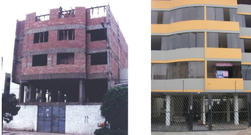
Fig.1. Ejemplo de edificios con “Piso Blando”.
