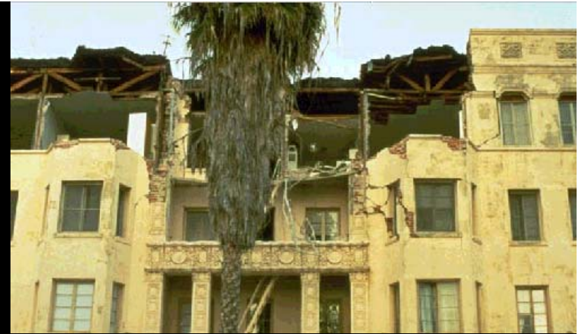
Albañilería No Reforzada
