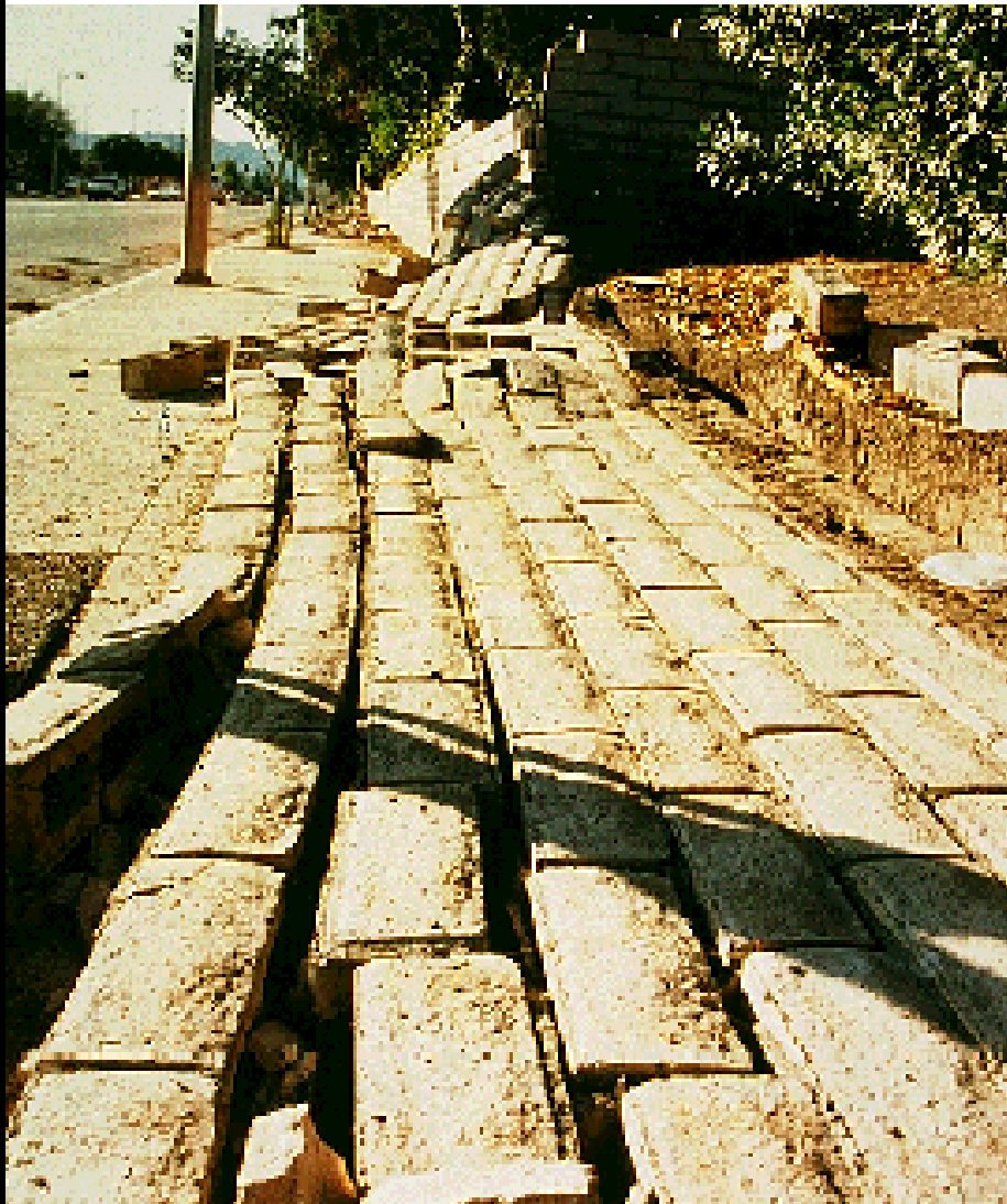
Cercos hechos con bloques de concreto
