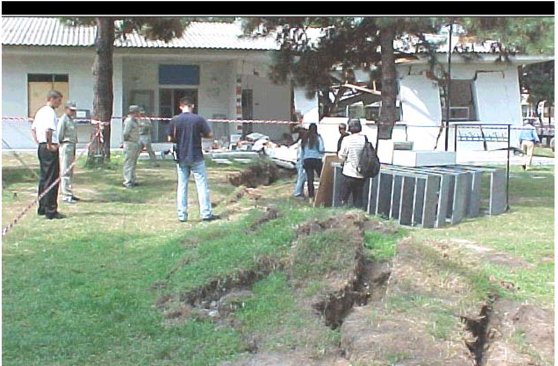
Casa sobre una falla
