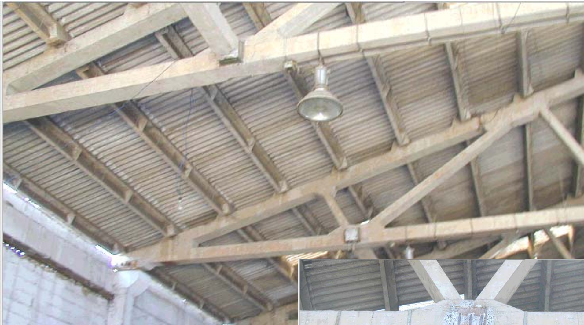
Tijeral de Concreto Armado
