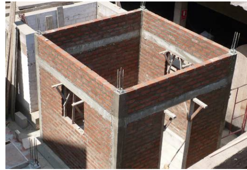
Fig. 3: vista del dintel del Módulo B
