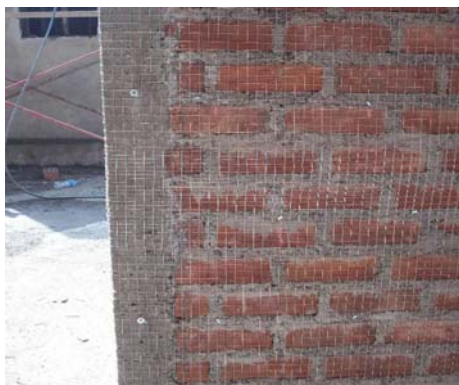
Fig. 4: Colocación de la malla
