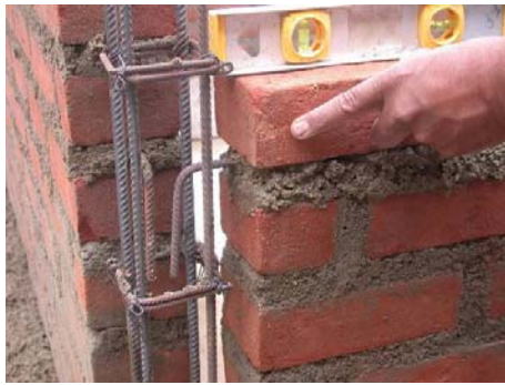
Fig. 2: acero en unión albañilería - columna
