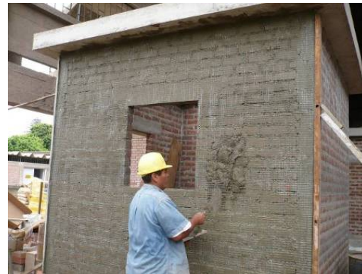
Fig. 5: Tarrajeo del muro E.
