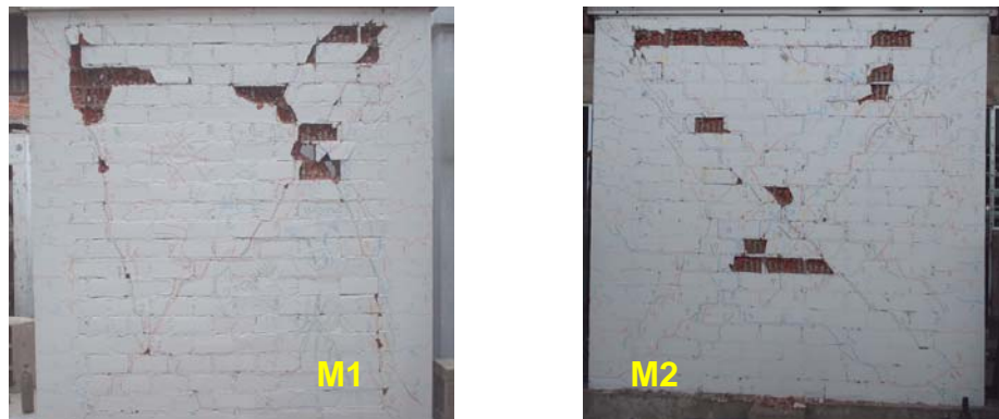
Fig.13 Prueba dinámica. Estado final.
