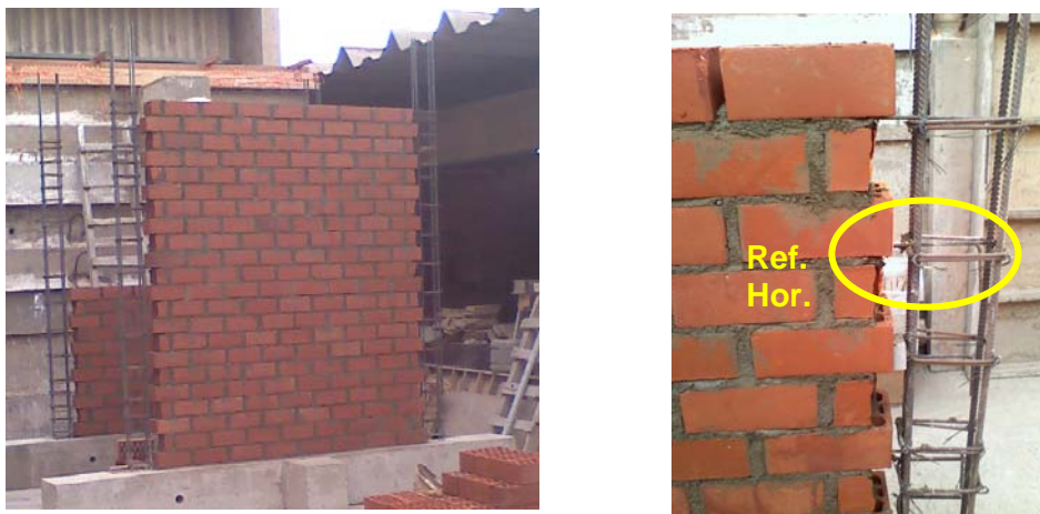
Fig.6. Secuencias de la construcción de M1 (izquierda) y M2 (derecha).
