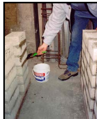
Fig.10. Curado de juntas en Técnica B.
