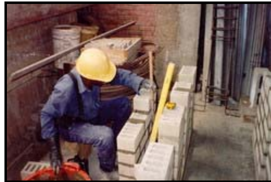
Fig.16. Control de la altura de las hiladas.
