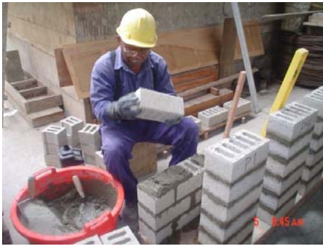
Fig.15. Asentado del ladrillo.
