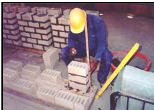
Fig.9. Control de la altura de las hiladas.
