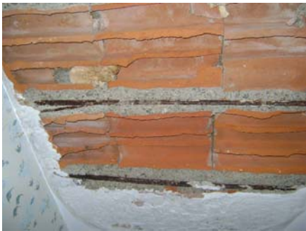
Fig.3. Casa 2. Aligerado del segundo nivel. Nótese el escaso recubrimiento del refuerzo positivo.
