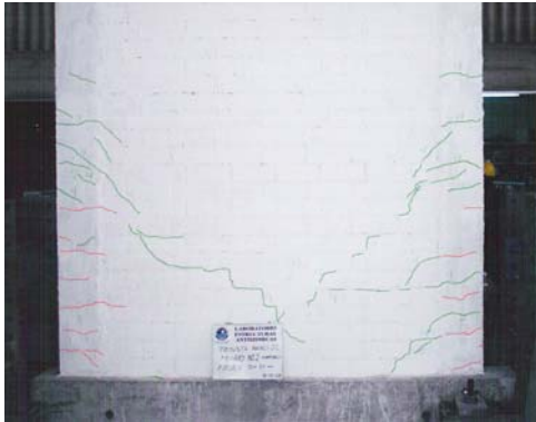
Fig.4. Fase 4. Muro Original.
