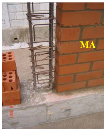
Fig.4 Secuencia en la construcción y mecha empleada.
