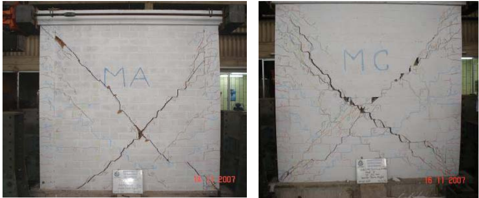
Fig.6 Muros MA (izquierda) y MC (derecha) al final del ensayo
