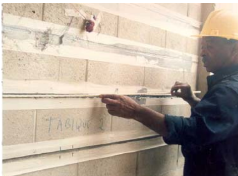
Fig.10.32. Varilla de fibra de vidrio adherida con epóxico al tabique.
