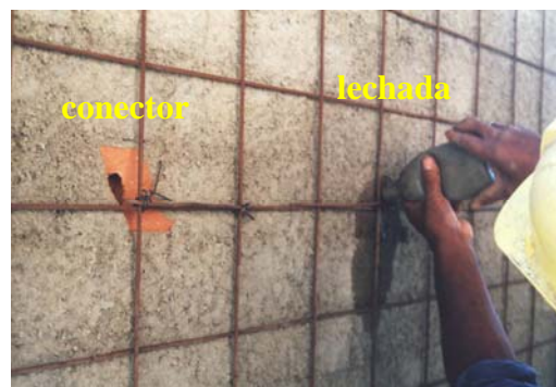
Fig.10.33. Mallas electrosoldadas conectadas con alambre #8 y recubiertas con mortero 1:4.
