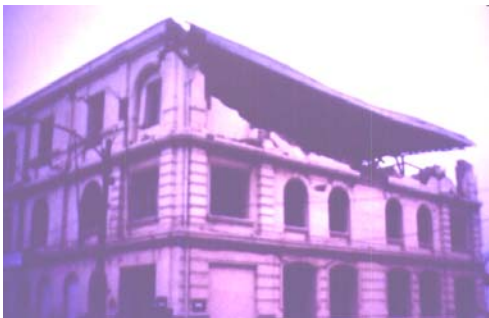
Fig.9.7. Techo metálico y ausencia de solera.
