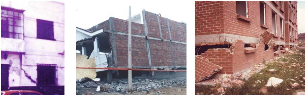
Fig.8.21. Falla del primer piso. Albañilería no reforzada (izquierda), albañilería confinada (centro) y albañilería armada (derecha). Ver además la Fig.8.17.
