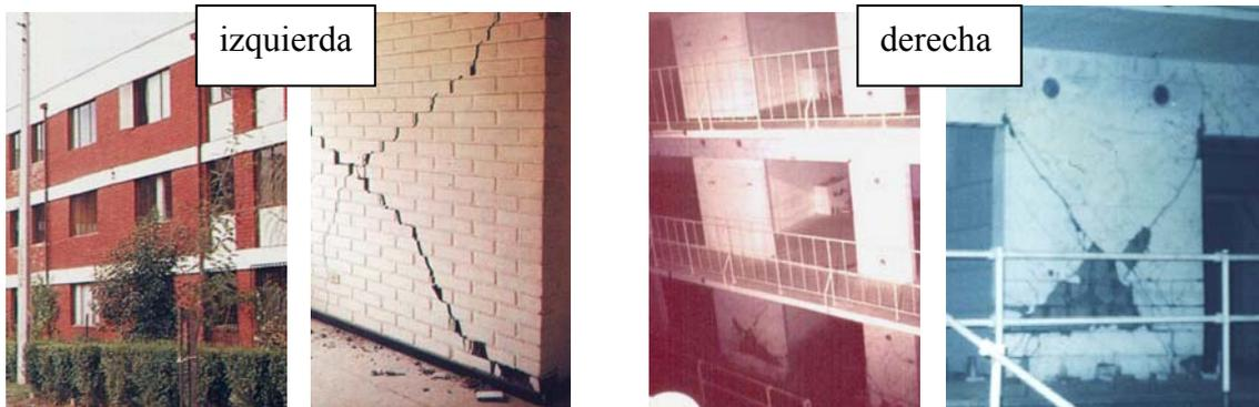
Fig.8.44. Falla por corte en muros de albañilería armada. Edificio de 3 pisos (izquierda) y espécimen de 5 pisos a escala natural (derecha).
