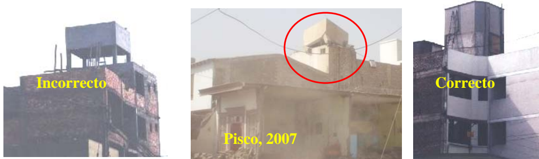
Fig.6.14. Tanques de agua y solución para evitar su colapso ante los sismos (derecha).
