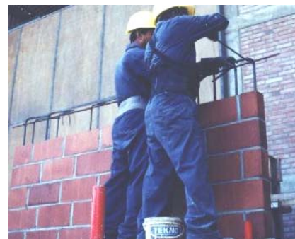
Fig.4.62. Inserción de barra vertical, traslape y fijación a barra horizontal temporal.
