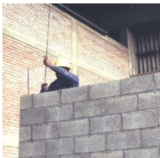
Fig.4.62. Inserción de barra vertical, traslape y fijación a barra horizontal temporal.
