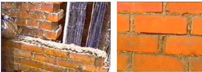
Fig.4.4. Errores en extensión del mortero y fluidez.
