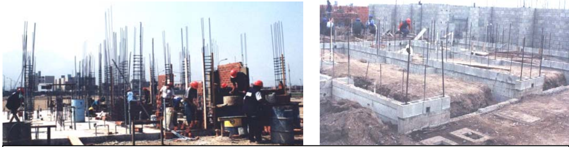
Fig.4.34. Refuerzo vertical en albañilería confinada (izquierda) y armada (derecha).
