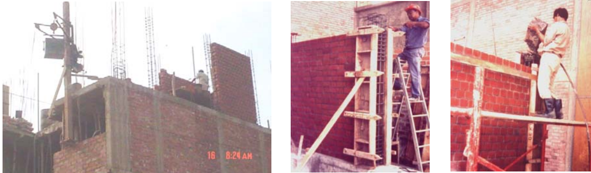
Fig.4.37. Secuencias de la construcción de las columnas.
