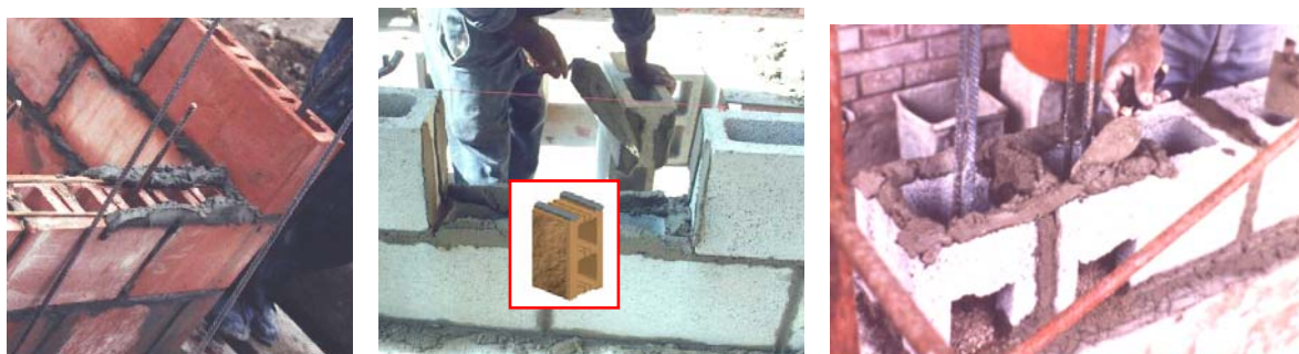
Fig. 4.3. Cintas de mortero tradicional (izquierda y centro) y junta llena (derecha).
