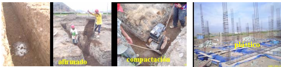
Fig.3.12. Impermeabilización de la cimentación en suelo húmedo.
