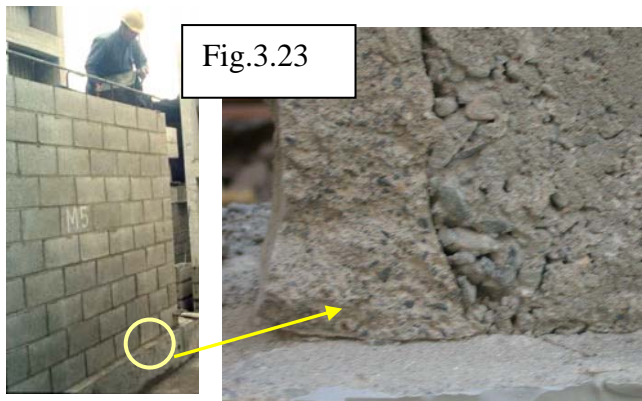
Fig.3.24. Segregación en la base.
