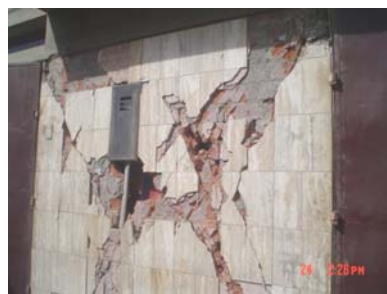
Fig.3.3 Trituración de ladrillos artesanales de arcilla en edificios de 3 pisos. Pisco, 2007.
