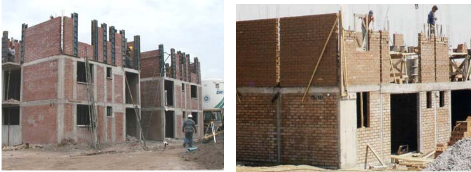
Fig.2.4 Secuencia en la construcción de la Albañilería Confinada.
