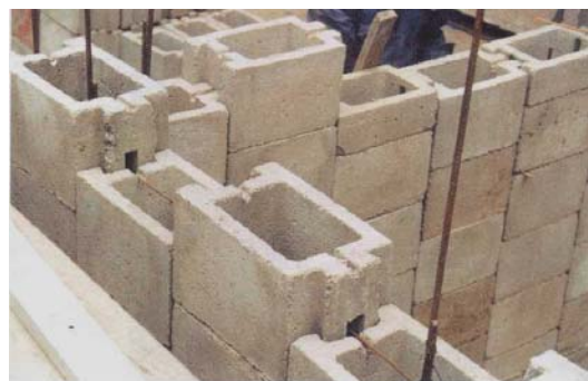
Fig.2.1. Unidades apilables de sílice-cal (izquierda) y de concreto (derecha).
