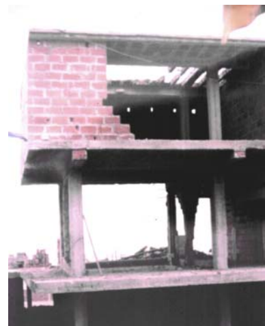
Fig.2.6. Colapso de parapetos y tabiques no arriostrados.
