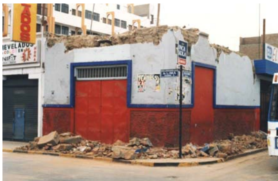
Fig.2.6. Colapso de parapetos y tabiques no arriostrados.
