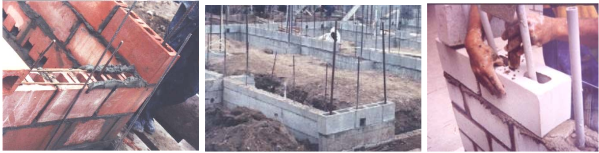
Fig.2.2. Bloques nacionales de arcilla (izquierda), concreto (centro) y sílice-cal (derecha).
