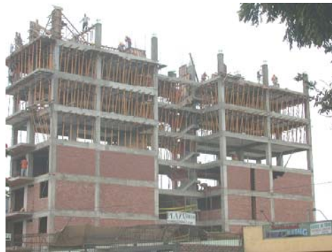
Fig.2.24 Tabiques de albañilería en una estructura aporticada.
