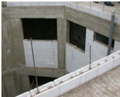
Fig.2.1. Unidades apilables de sílice-cal (izquierda) y de concreto (derecha).
