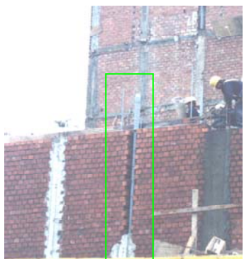
Fig.1.21 Falsa columna. Nótese las mechas horizontales embutidas en la albañilería, para conectar las partes divididas del muro.
