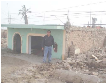
Fig.1.7. Suelos no aptos para la construcción. Licuación en Tambo de Mora en el sismo de Pisco del 15-08-2007 (izq.), y arcilla expansiva en Talara (derecha).
