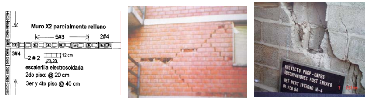
Fig.1.13. Muro armado parcialmente relleno y trituración de celdas vacías.
