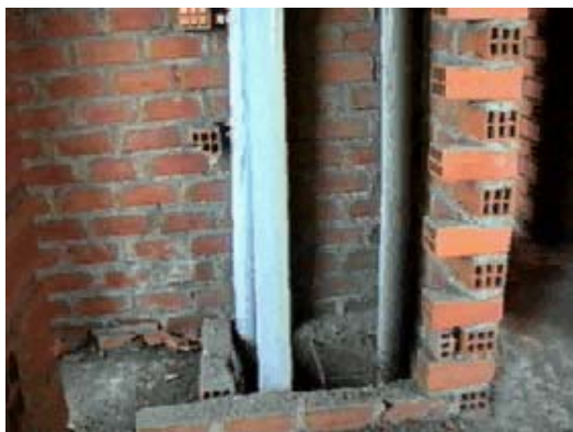
Fig.1.23. Ducto (izquierda) y zona de servicios alrededor de un ducto (derecha).
