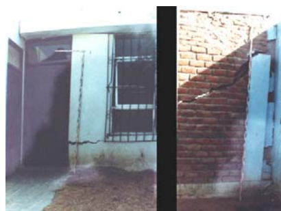
Fig.1.6. Fractura en una vivienda ubicada sobre suelo blando (izquierda) y cimentación rígida recomendada para estos casos (derecha).
