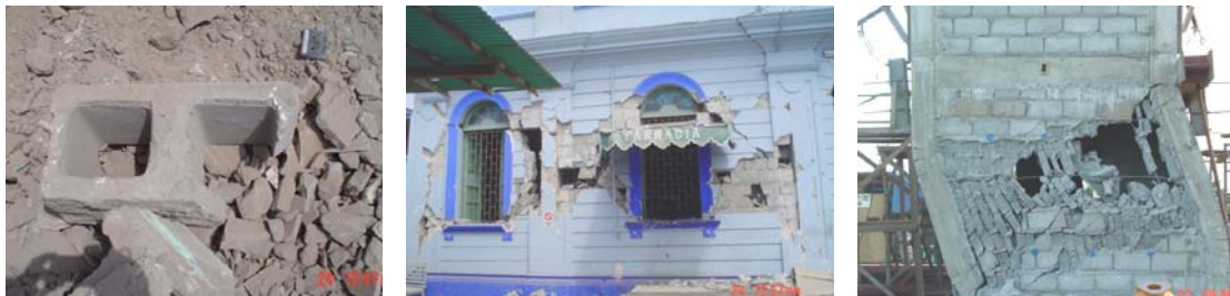
Bloques de concreto vacíos. Estas unidades fueron creadas para ser usadas en la construcción de la Albañilería Armada rellena con grout.
