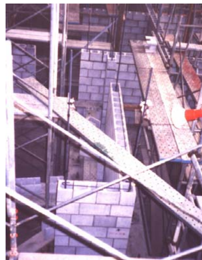
Fig. 1.1. Albañilería Confinada (izquierda) y Albañilería Armada (derecha).
