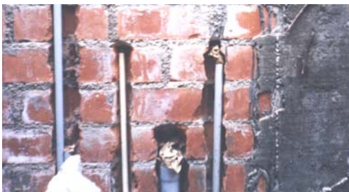
Fig.1.18. A la izquierda se presenta una situación no permitida por la Norma E.070, y a la derecha se aprecia una cavidad dejada durante la construcción de la albañilería, que luego será rellenada con concreto líquido (grout).
