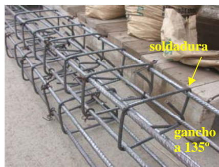
Fig.1.26 Canastilla electrosoldada.
