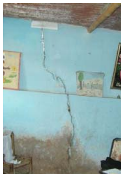
Fig.1.6. Fractura en una vivienda ubicada sobre suelo blando (izquierda) y cimentación rígida recomendada para estos casos (derecha).
