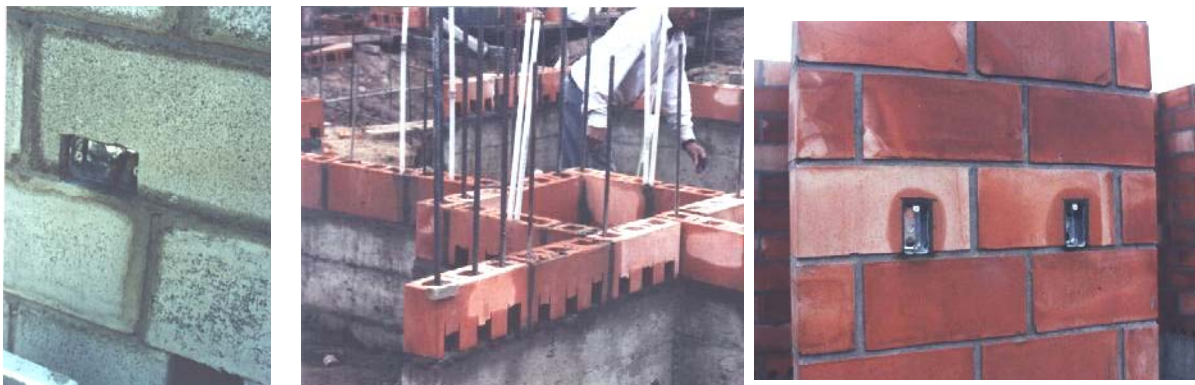
Fig.1.20. Paso de conductos en muros armados.
