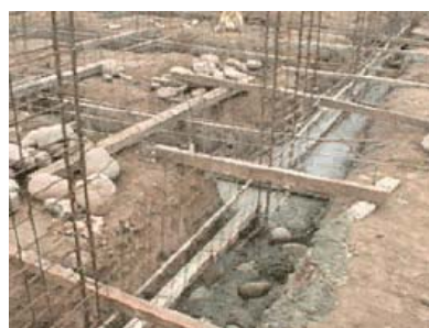
Fig. 1.11. Cimiento corrido de concreto ciclópeo.
