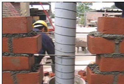
Fig.1.21 Falsa columna. Nótese las mechas horizontales embutidas en la albañilería, para conectar las partes divididas del muro.
