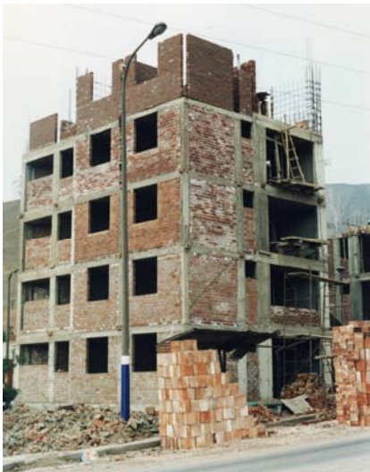
Fig. 1.1. Albañilería Confinada (izquierda) y Albañilería Armada (derecha).
