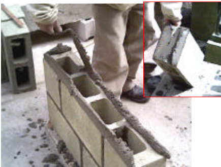
Fig.3. Técnica 1. Juntas de mortero en cintas.
