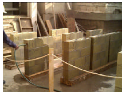
Fig.6. Técnica 4. Curado externo de la albañilería.
