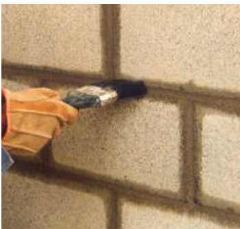
Fig.5. Técnica 3. Curado externo de las juntas.
