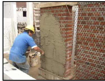
Figura 5. Tarrajeo de los muros.
