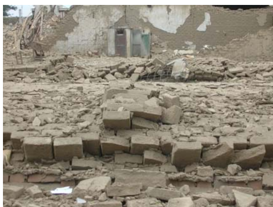
Figura 2. Muestra de la baja adherencia en las construcciones de adobe.
