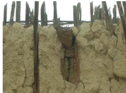
Detalle apoyo viga interior sobre pared
