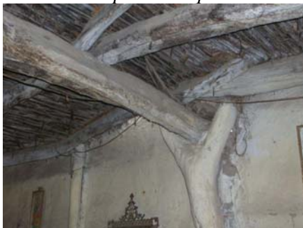
Detalle estructura postes y vigas
