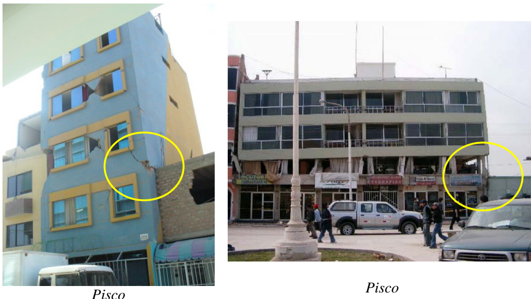
Figura 17. Choque entre edificios
