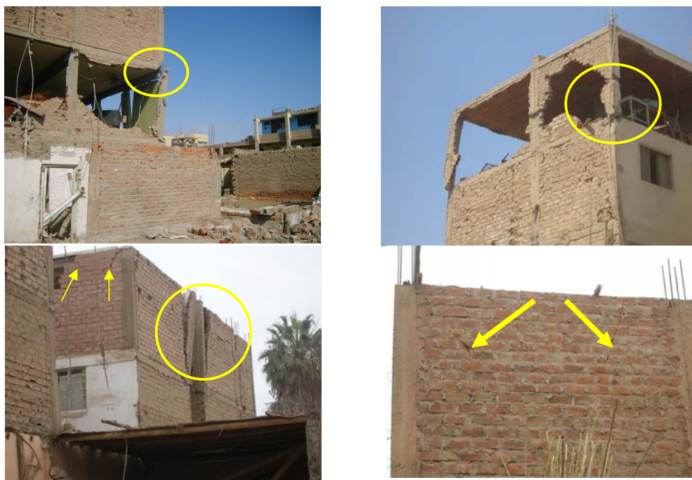
Figura 11. Daños en edificios de albañilería reforzada
