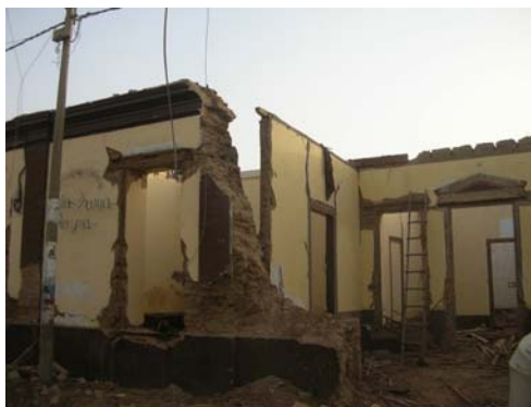
Detalle encuentro tabique interior-muro
