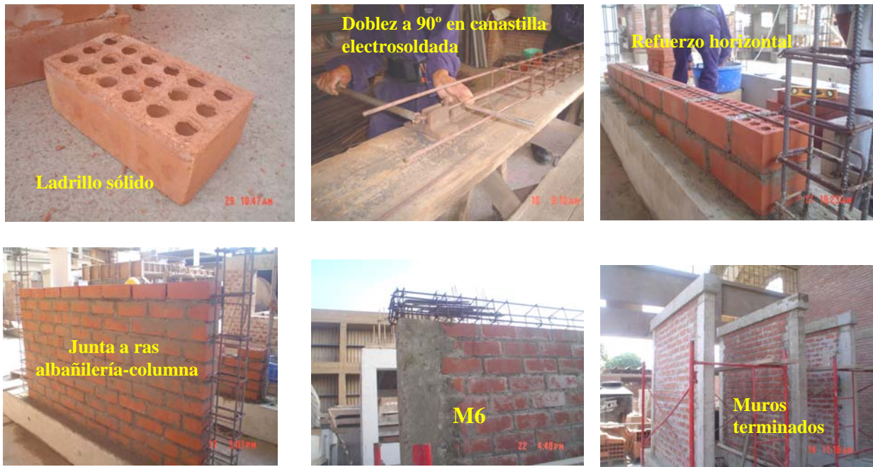
Fig.9. Secuencias de la construcción de los muros 6 muros confinados.
