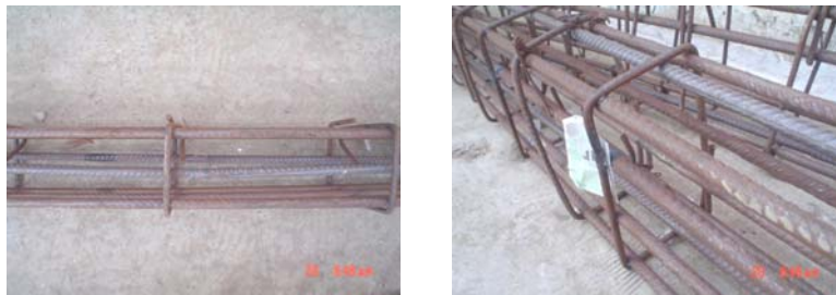
Fig.6 Canastilla de M6 con varilla longitudinal interna doblada.
