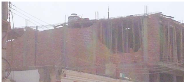
Fig.9. Volcamiento de muros con junta a ras con las columnas. Inadecuadamente las columnas fueron construidas primero y después se levantó la albañilería. Pisco.
