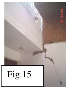
Fig.13. Primer piso de adobe y segundo piso de albañilería. Pisco.
