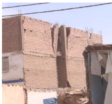
Fig.21. Muros sin solera y con columna discontinua (izquierda), y espaciamiento entre arriostres verticales muy grande (derecha).
