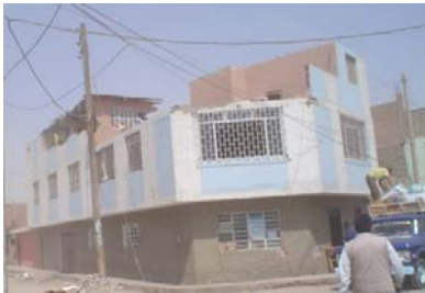
Fig.25 Pisco, parapeto sin arriostrar (izq.) y arriostrado en el tercer piso (der.).
