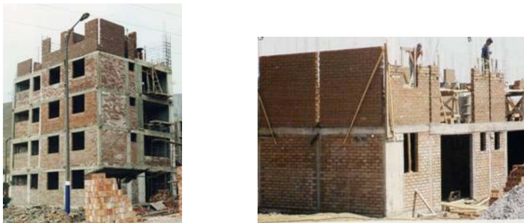
Figura 1. Secuencia constructiva en edificaciones de albañilería confinada
