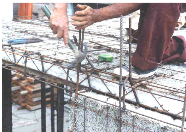
Foto 2 - Detalle de la conexión techo-muro
