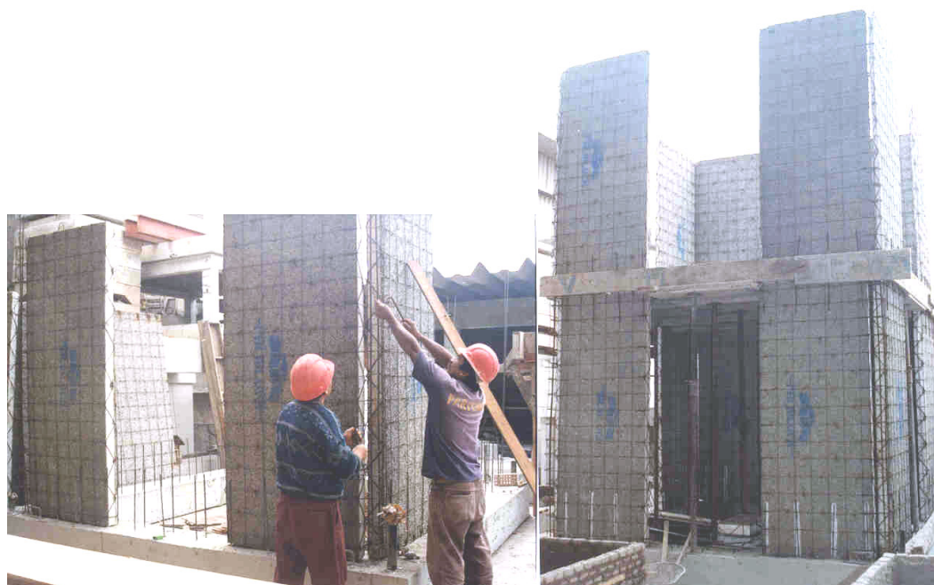
Foto 1 - Montaje de los Paneles
