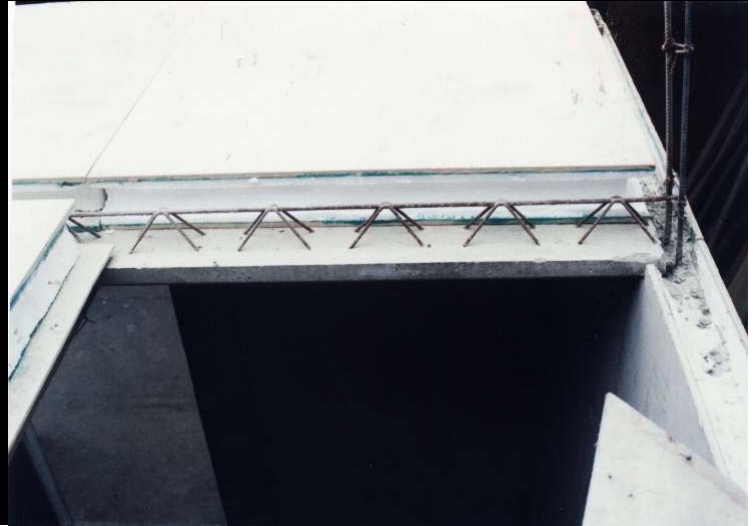
Montaje de los paneles de techo sobre las viguetas prefabricadas
