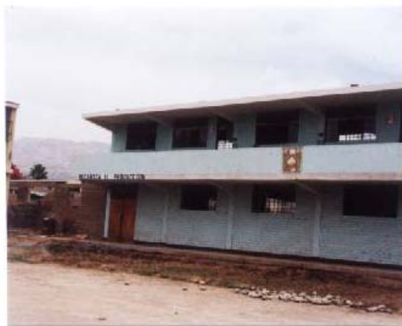
Fig.5. Colegio Fermín Tangüis, Palpa. Pabellón sin Daños.
