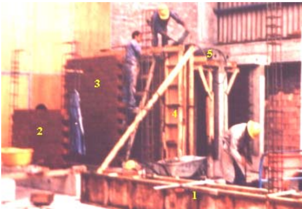
Fig.16. Secuencia seguida en la construcción de los muros.
