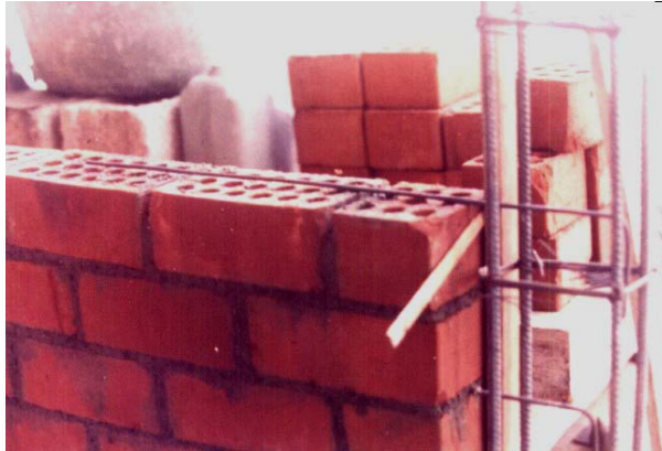
Fig.2. Chicote de anclaje en el Muro 2.
