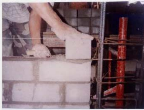
Fig.5. Conexión a Ras con Mechas de Anclaje.
