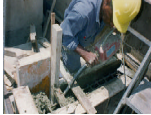
Foto 10. Construcción de la viga de concreto. Nótese el emparrillado y el vibrado del concreto.
