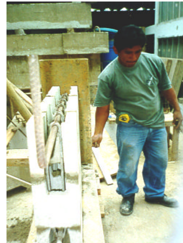
Foto 7. Construcción de la tercera hilada de la viga de albañilería. Nótese el refuerzo longitudinal
