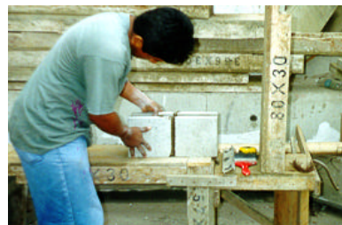
Foto 5. Construcción de la primera hilada de la viga de albañilería. Nótese la junta vertical.
