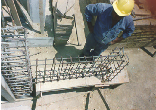
Foto 10. Construcción de la viga de concreto. Nótese el emparrillado y el vibrado del concreto.
