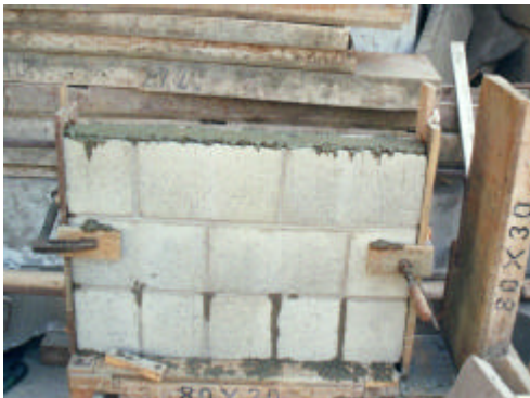
Foto 8. Vaciado del Grout en la viga de albañilería
