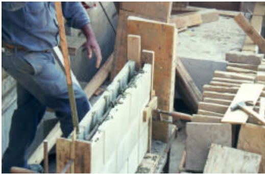
Foto 7. Construcción de la tercera hilada de la viga de albañilería. Nótese el refuerzo longitudinal
