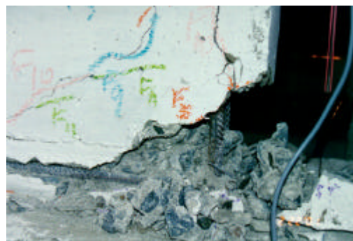
Foto 14. Trituración del talón en la viga de concreto.
