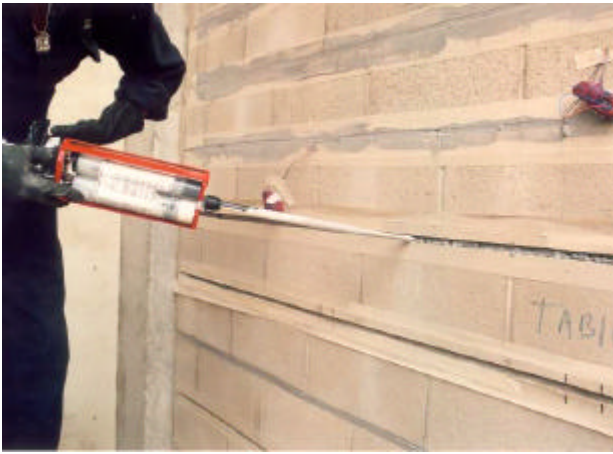
(a) Aplicación de la pasta de epóxico
