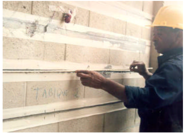
(b) Instalación de las varillas de fibra de vidrio
