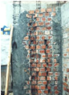
Fig.1. Desintegración columna-muro.
