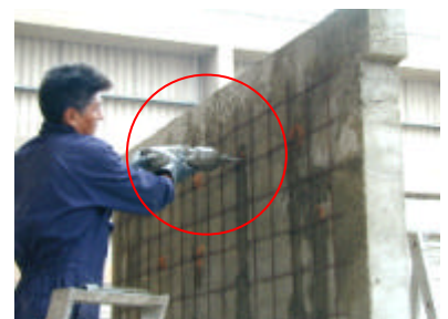
Fig.7. Atortolado de la malla con los conectores (izq.) y taponado de las perforaciones con lechada de mortero 1:3 con un inyector (der.).
