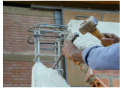
Fig. 5. Picado y resane con mortero en las grietas gruesas (izq.) y picado de uno de los nudos con el retiro de los ladrillos triturados (der.).
