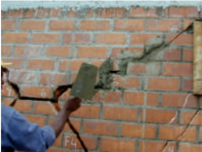
Fig. 5. Picado y resane con mortero en las grietas gruesas (izq.) y picado de uno de los nudos con el retiro de los ladrillos triturados (der.).
