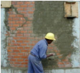
Fig.6. Pañeteo del muro (izq.) y perforaciones con cincel (der.).
