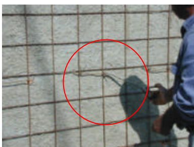
Fig.7. Atortolado de la malla con los conectores (izq.) y taponado de las perforaciones con lechada de mortero 1:3 con un inyector (der.).
