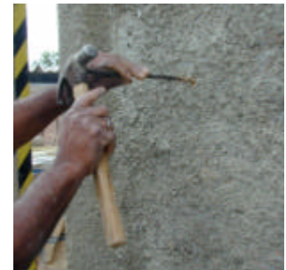
Fig.6. Pañeteo del muro (izq.) y perforaciones con cincel (der.).
