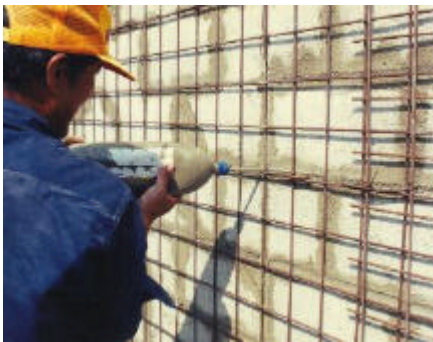
Fig.9 (izq.) Inyección de lechada en las perforaciones.
