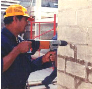
Fig.7 (izq.) Perforación del muro. Allí se instalaron los conectores.
