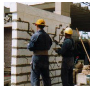
Fig.5 (izq.) Ranurado con amoladora de las fisuras principales.
