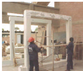
Fig.2 Pórticos de concreto armado.
