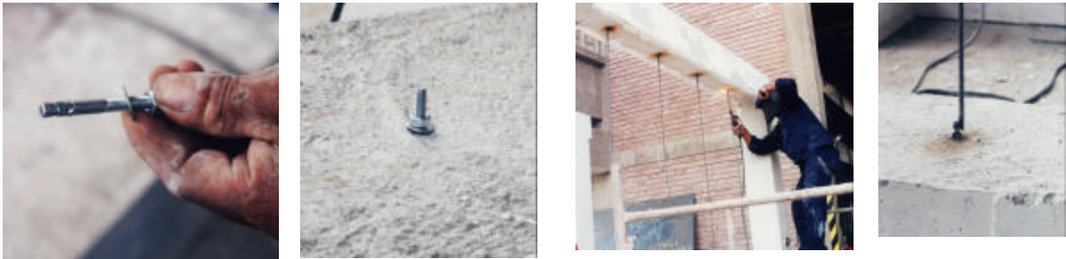
Fig.3. Perno expansivo y soldadura con las varillas del tabique.
