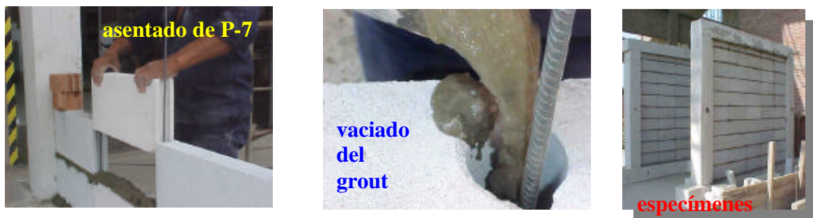
Fig.4. Construcción del tabique con Placa P-7.
