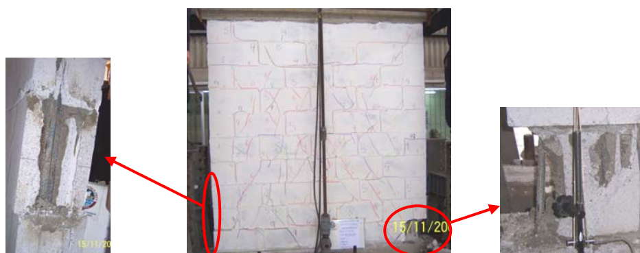
Fig.10. Muro M-1 al término del ensayo.
