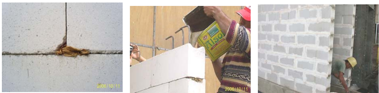
Fig.7. Taponado de rendijas, vaciado del grout y masillado de las juntas.
