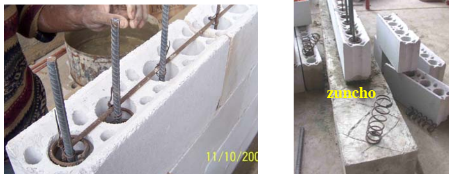
Fig.6 Refuerzo horizontal y zunchos en M-2
