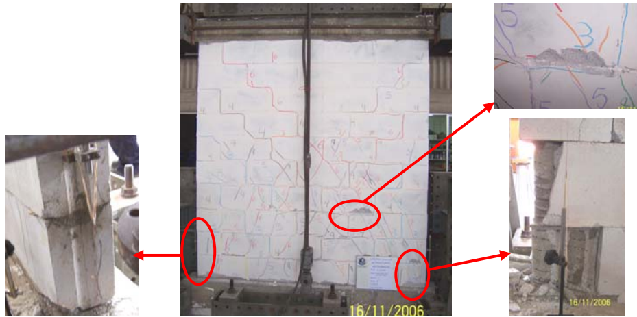
Fig.11. Muro M-2 (con zunchos) al término del ensayo.
