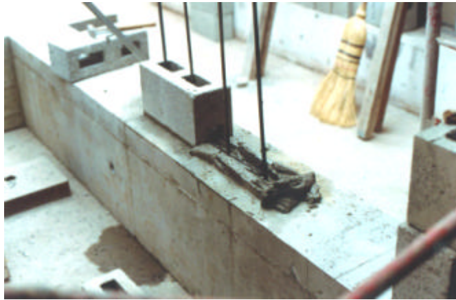
Foto 2. Asentado de la primera hilada. Nótese que el mortero sólo cubre los bordes del bloque.
