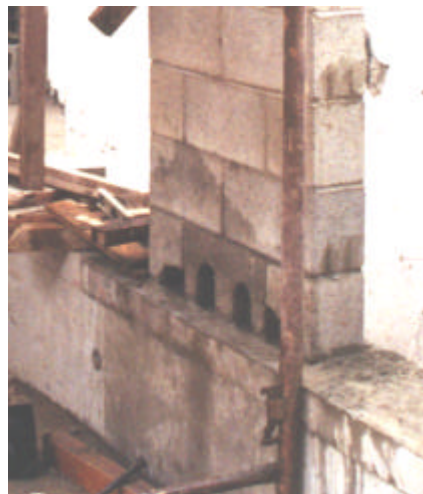
Foto 3. Registros de limpieza en la primera hilada.
