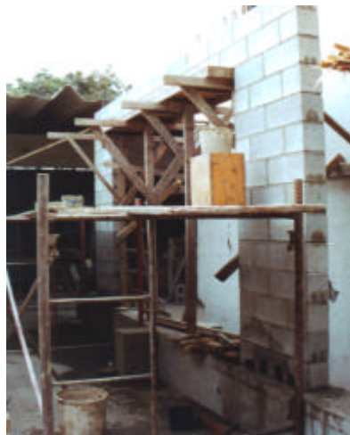
Foto 4. Pórtico antes de ser rellenado con grout.
