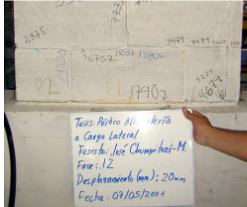
Foto 6. Deslizamiento en la base producido en la Fase 9.
