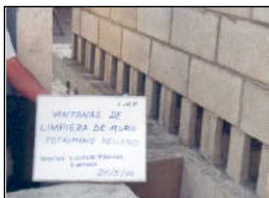
Foto 3. Ventanas de limpieza en muros totalmente rellenos.
