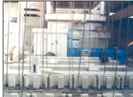
Foto 2. Primera hilada de los muros totalmente rellenos
