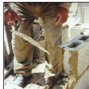
Foto 4. Junta vertical en un bloque asentado.
