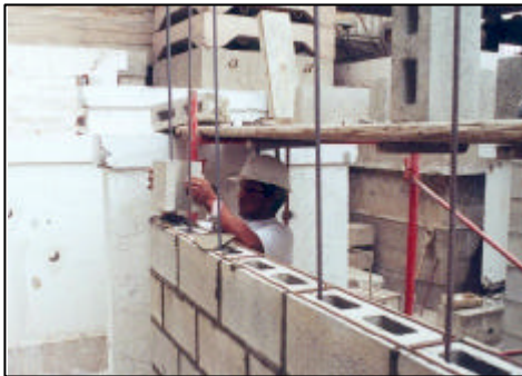
Foto 7. Refuerzo de Escalerilla en los muros E.
