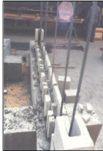
Foto 6. Refuerzo de acero corrugado horizontal en los muros P y R.
