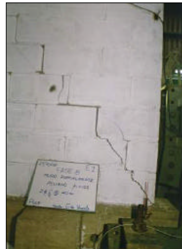
Foto 12. Falla por corte (Muro E1)
