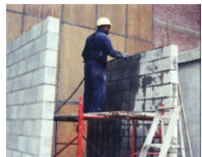
Fig.15. Tratamiento con agua en M4 y M5. Ver el párrafo 3.8.
