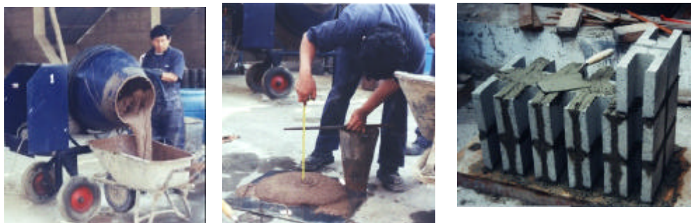
Fig.9 Preparación del grout y construcción del pilar.
