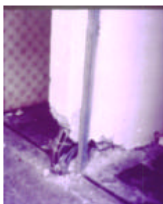
Fig.6. Transformación de la falla por flexión en falla por deslizamiento.
