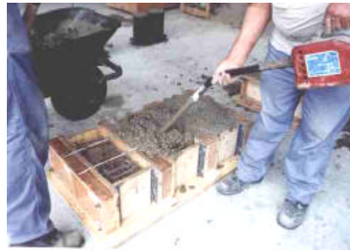
Foto 5. Vaciado y vibrado del concreto
