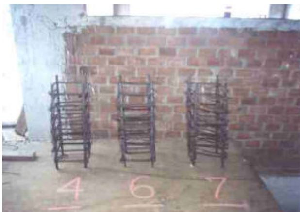
Foto 3. Refuerzo vertical y transversal utilizado en los casos 4, 6 y 7.
