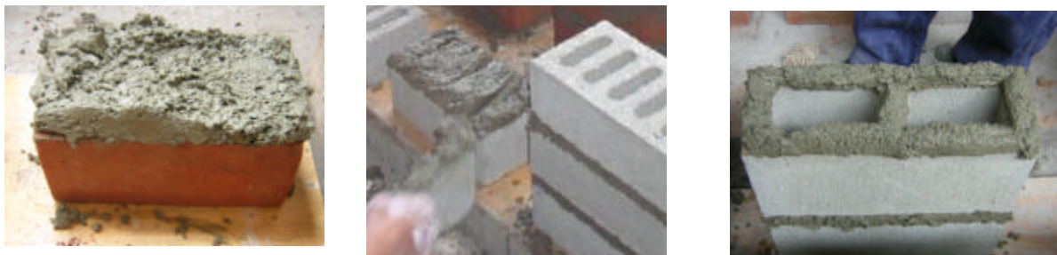
Fig.7. Mortero cubriendo la superficie de asentado. De izquierda a derecha: ladrillo de arcilla, ladrillo de concreto y bloque de concreto.
