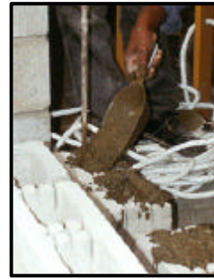
Foto 5 Vaciado del grout
