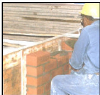
Foto 1 Construcción de muretes
