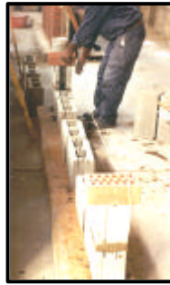
Foto 4 Colocación de cuerda para la alineación de la hilada
