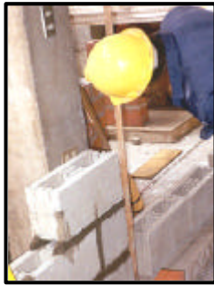
Foto 3 Verificación de la altura de la hilada
